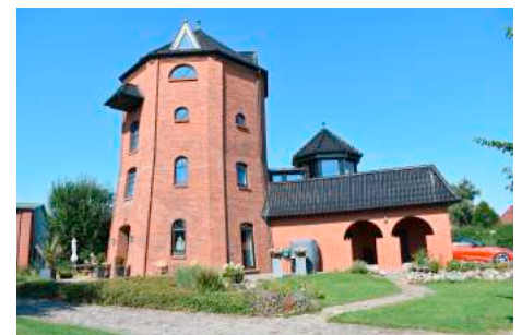
Ein Referenzobjekt mit renovierten Fenstern
