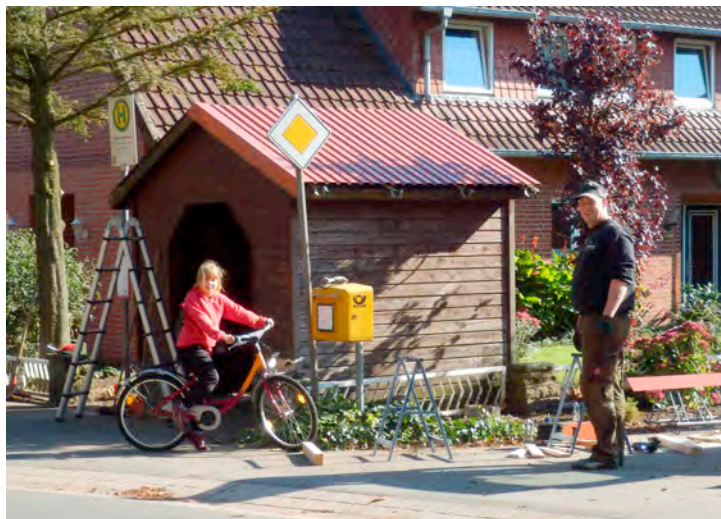
Arbeiten am Buswartehäuschen bei Ellinghausen in Uepsen
