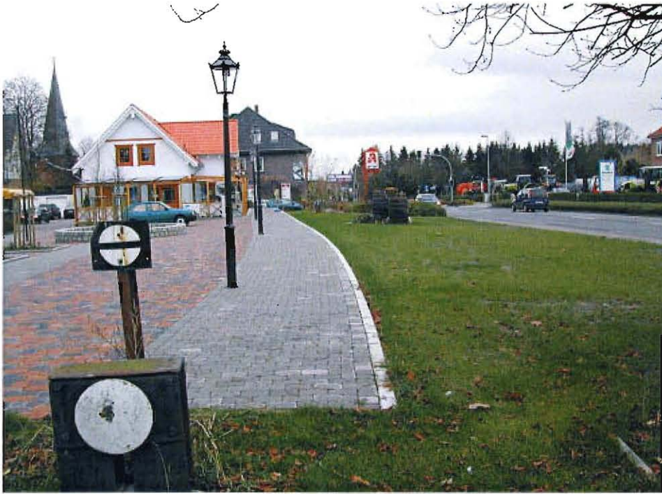
Ein Bahnsteig - noch ohne Gleis
