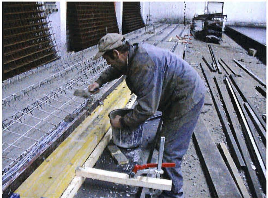
Fertigteile sind auch Handarbeit
