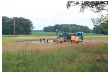
Aufgrund umfangreicher PAK (Polyzyklische Aromatische Kohlenwasserstoffe) Belastungen wurde für die Wege im Bereich Hohenmoor die kostengünstigere Variante mit dem Wegeaufbau auf der bestehenden Straßendecke gewählt. Zum Ausgleich der Seitenräume wurden dafür allerdings größere Mengen Boden benötigt. In Abstimmung mit dem Eigentümer und der Unteren Natur-
